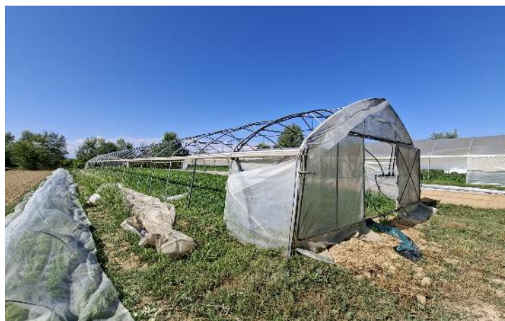
Serra danneggiata dal forte vento.
